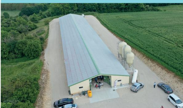
La toiture est entièrement recouverte d'une couverture en fibrociment. Alors que le prix de la tôle augmente de plus en plus, Serupa voit dans ce type de matériaux une alternative d'avenir. Sans amiante, elle est très fiable sur le long terme avec des propriétés isolantes intéressantes, le tout pour un rapport qualité-prix particulièrement attractif.
