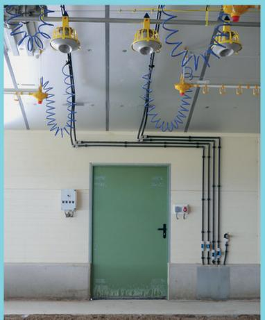
Le boîtier de régulation Serenity (Tuffigo-Rapidex) centralise tous les paramètres automatisés de l'élevage avec une interface commune à tous les appareils, que ce soit sur le moniteur principal, le PC ou le téléphone portable.
