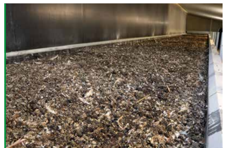
Des turbines pompent l'air chaud du poulailler et le propulsent sur les deux tapis de séchage des fientes du séchoir, qui sont en tôle perforée. © Germain Schmitt
