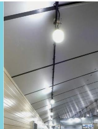
↑ Afin d'obtenir une meilleure homogénéité au sol, les salles d'élevage sont éclairées avec un maillage dense d'ampoules Led.
