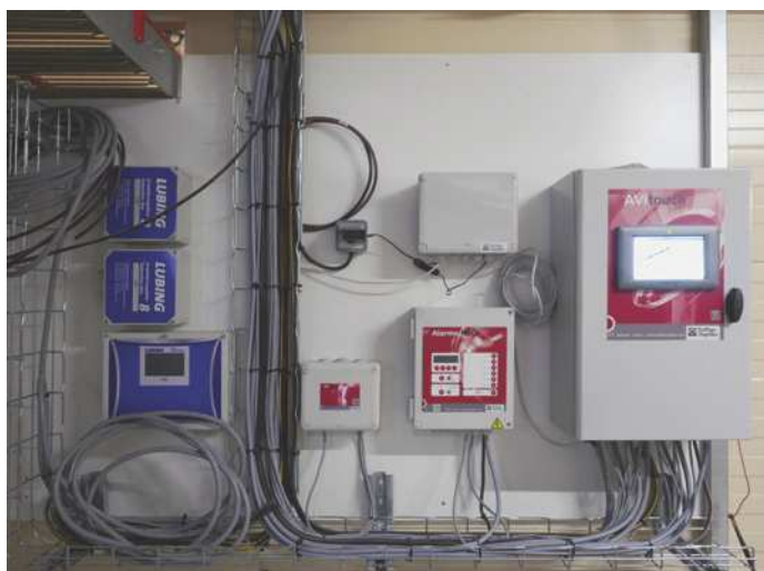
Christophe François a choisi une purge automatique Lubing en option gérée depuis la salle d'élevage, à côté de l'ordinateur central AviTouch (Tuffigo-Rapidex).
