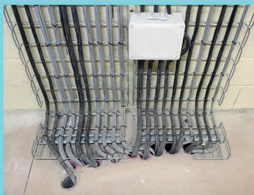
L'installation hydraulique et électrique du bâtiment passe entièrement par voie souterraine ce qui représente un avantage sur le plan de l'hygiène et de la sécurité. Un local sécurisé coupe-feu avec le mur et le sol en béton armé et les murs en aggloméré regroupe les terminaux électriques du bâtiment, ce qui présente aussi un avantage auprès des assurances.
