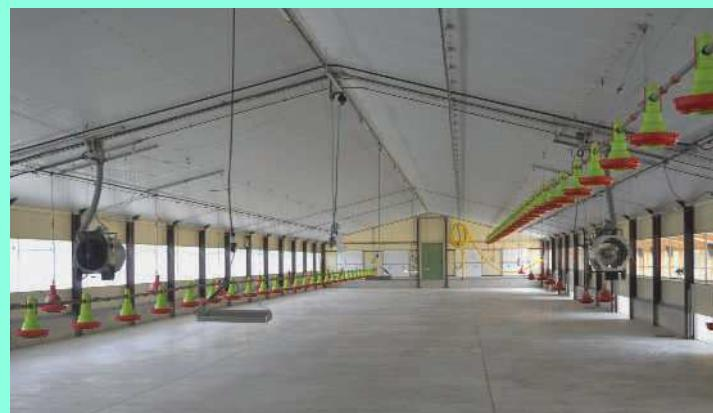
↑ L'éclairage naturel est complété par une rangée centrale de néons leds (1,8 m, 18 W). Deux pesons automatiques ont été prévus par bâtiment. Deux canons aérothermes à gaz (KT130, Systel) assurent le chauffage en ambiance complétés par une ligne centrale de radiants électriques (Intertec) mise en place par sécurité.
