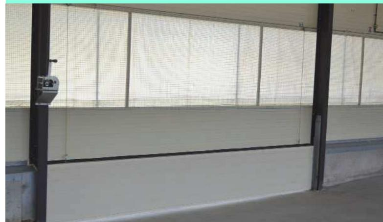
↑ L'ouverture des rideaux (1 m) est gérée par l'Avitouch (Tuffigo-Rapidex), de même que la ventilation, la brumisation, l'alimentation, l'éclairage. Les bâtiments sont équipés de caméras à 360° consultables à distance pour vérifier la bonne répartition des animaux. Les bâtiments sont équipés d'une Vigibox.
