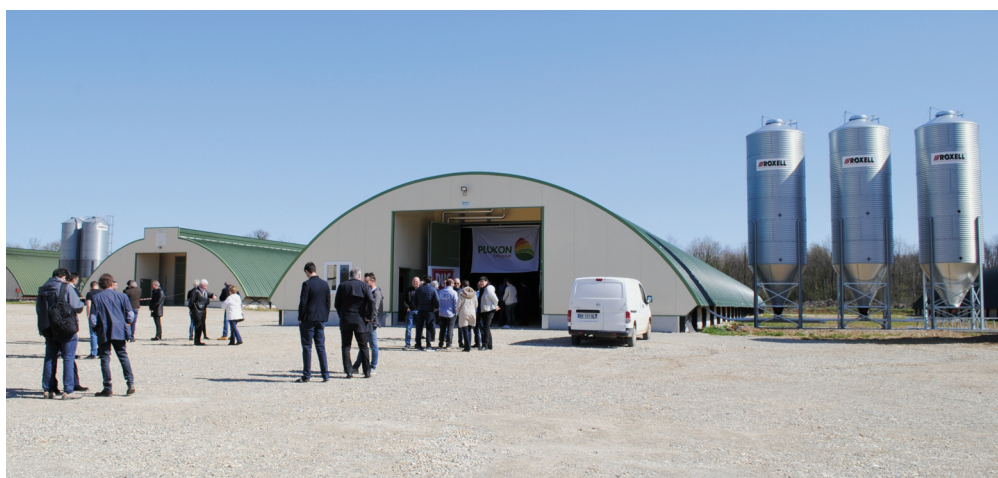
Les deux bâtiments « tunnels » de 1500 m 2 construits par la société Serupa.
